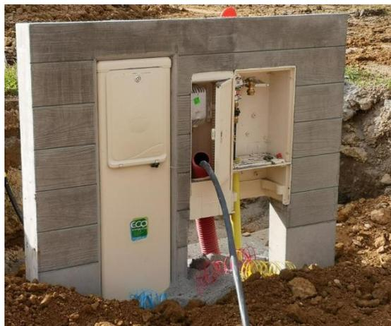
**Figure 4 : exemple de muret technique**
